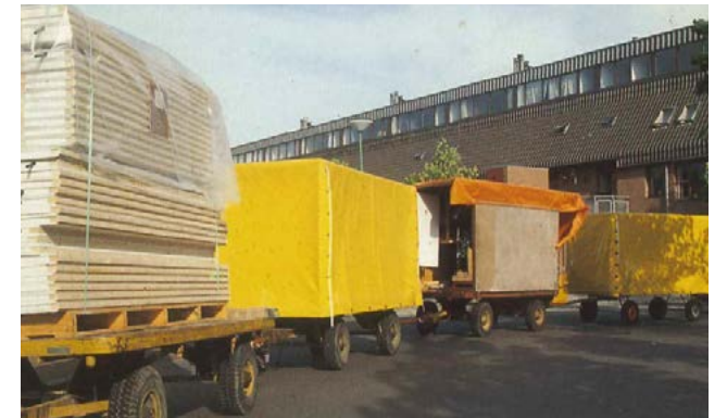
Begin jaren 80 850 woningen in Almere gerenoveerd door Trebbe
