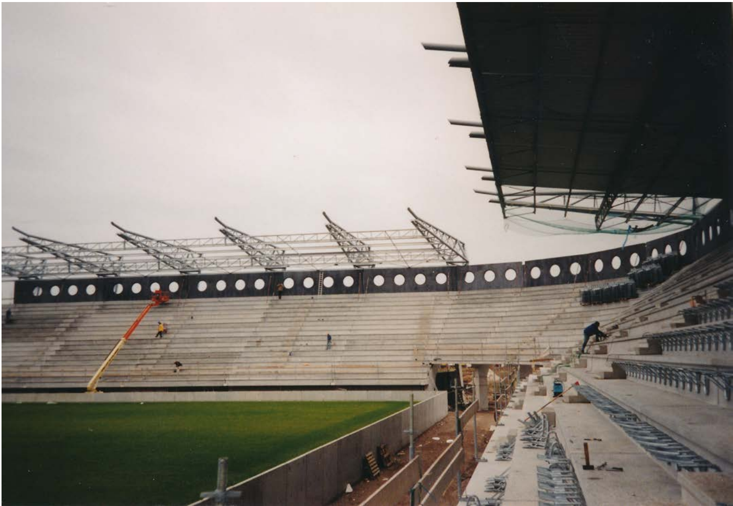
1997 Bouw van het Arke Stadion (later Grolsch Veste)
