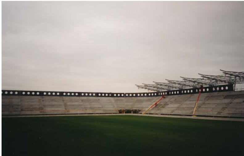
1997 Bouw van het Arke Stadion (later Grolsch Veste)
