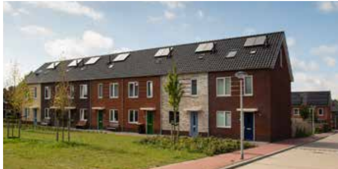
Kop De Veste, Lelystad Centrada / Peters & Lammerink architecten
